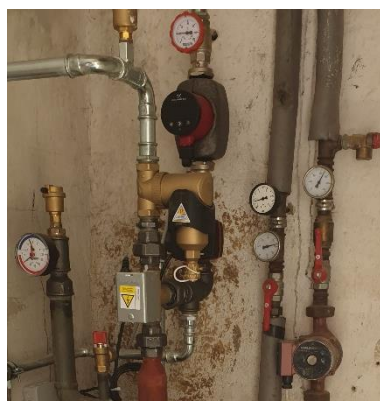
Alte Heizungspumpen
